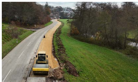
Arbeiten am Planum im Bereich des Leintalradweges
