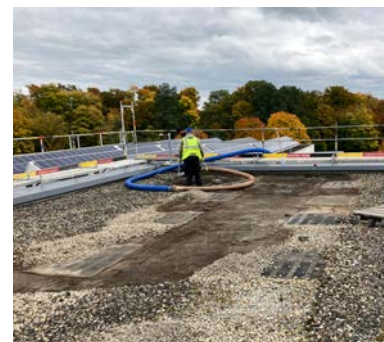
Demontage der PV-Anlage und Beginn der Entkiesungs- arbeiten
