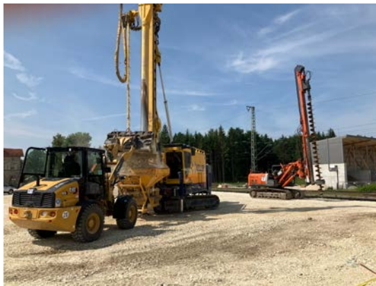
K 3335 Rüttelstopfsäulen am Bahnhofsvorplatz
