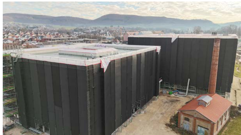
Blick auf Gebäude 1 im Bildvordergrund mit vier Obergeschossen und das unterkellerte Gebäude 2 mit fünf Obergeschossen (Luftbild Dezember 2025)
