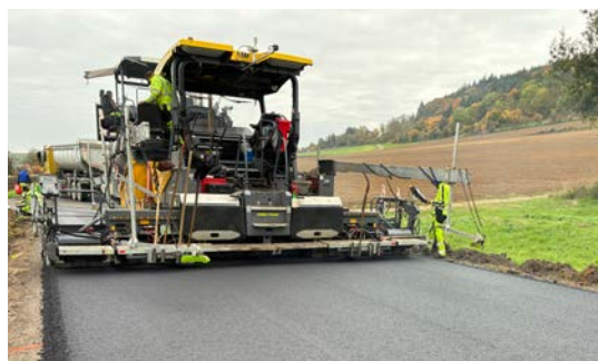
Asphalteinbau an der K 3316 bei UtzmemmingenLeintalradweges
