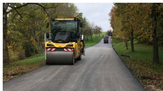
Walzarbeiten K3200 Kahlhöfe - Baldern
