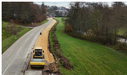
Arbeiten am Planum im Bereich des Leintalradweges
