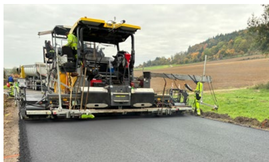
Asphalteinbau an der K 3316 bei UtzmemmingenLeintalradweges
