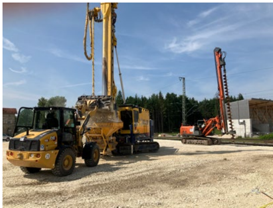
K 3335 Rüttelstopfsäulen am Bahnhofsvorplatz
