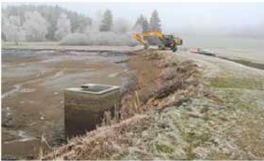
Mit einigem Aufwand war die Sanierung des Damms des oberen Weihers sowie die Entlandung des unteren Weihers in den Essinger Weiherriesen verbunden, die der LEV im Auftrag des RP Stuttgart mitbetreute.
