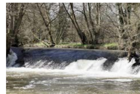
Das knapp 20 Meter breite Leinwehr an der Horner Mühle vor dem Rückbau.
