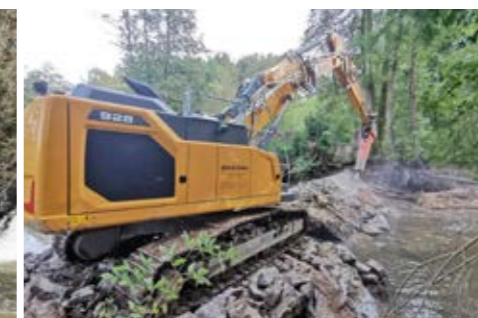
Rückbauarbeiten im Oktober 2023: Das Wehr wird mit dem Baggermeißel vollständig abgebrochen.
