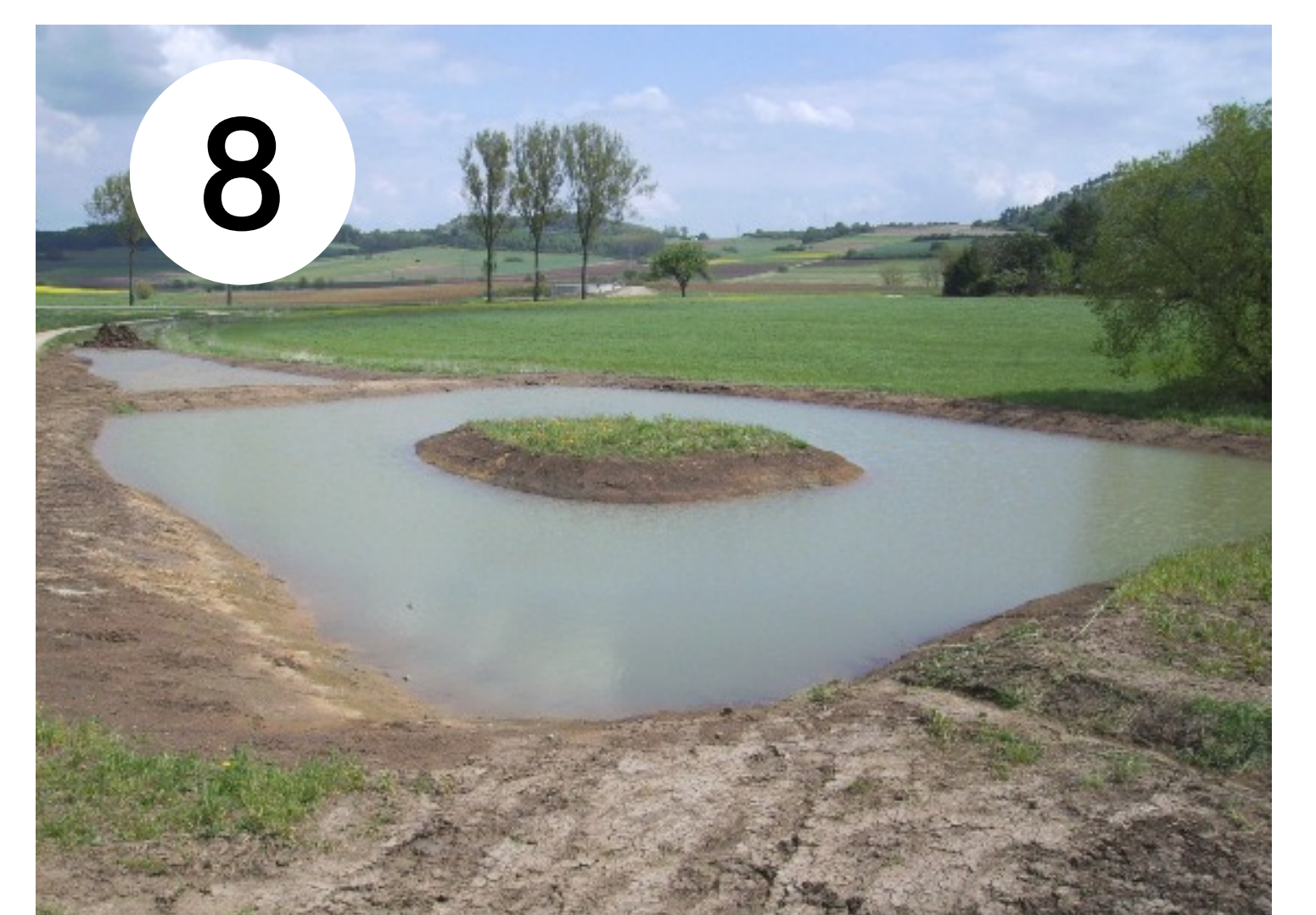
Erstellung einer Teichanlage mit Tief- und Flachwasserzonen
