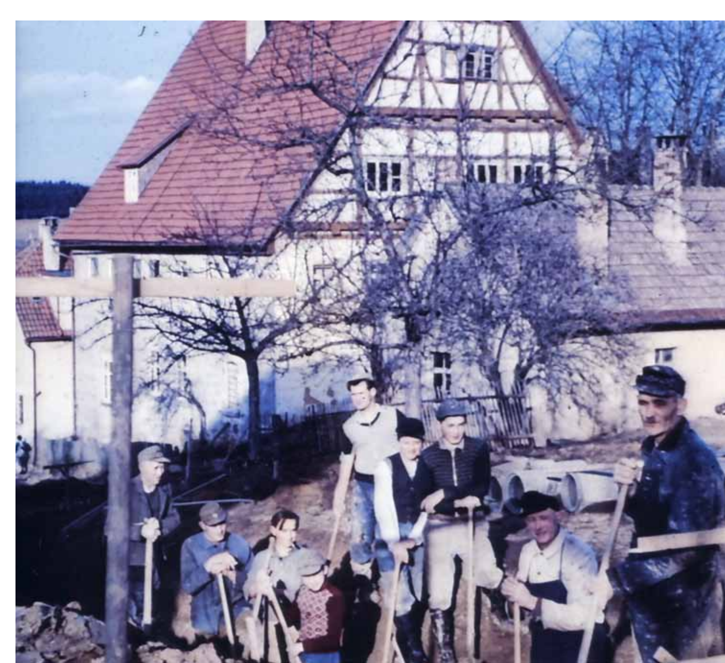
In den meisten Dörfern begann man seit Ende der 1950er Jahre mit dem Aufbau einer kommunalen Abwasserbeseitigung. Dabei wurden die Abwasserrohre meist noch in Handarbeit verlegt, wie hier in Dewangen.
