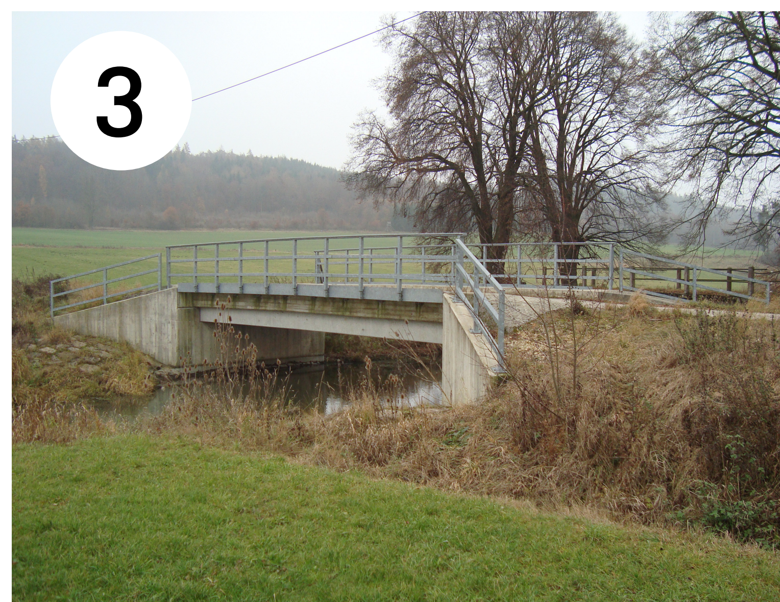
Modernisierung von Feldwegebrücken
