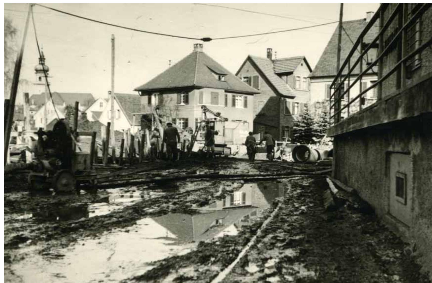
In den Städten, wie hier in Aalen, begann man meist schon Anfang der 1950er Jahre mit dem Aufbau einer Abwasserbeseitigung..
